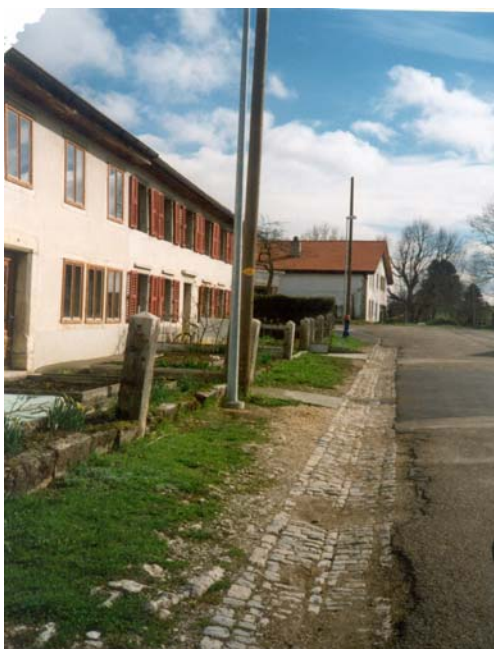
Rigole et bande verte marquant la transition entre espace public et espace privé
