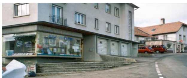
Perrons qui permettent l'adaptation à la pente
