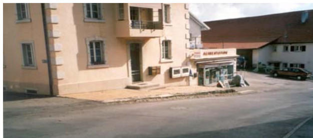
Socle de bâtiment en béton, élément de liaison entre le bâti et l'espace-rue
